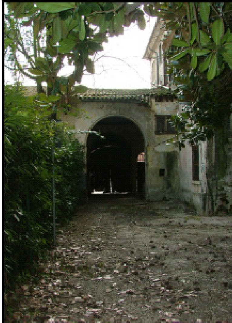
VISTA NORD EST
